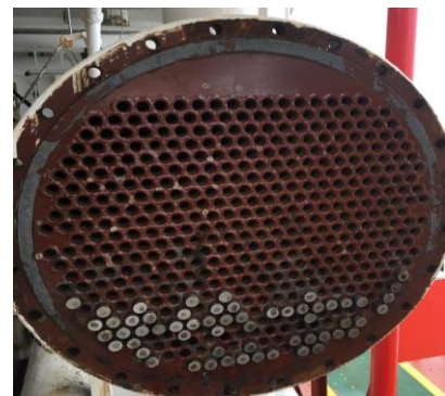
Gambar 1. Tube flow pada cargo heater
